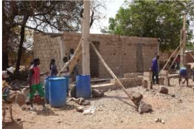
Die Räume für die Frauenkooperative in Faraba sind bald fertig
